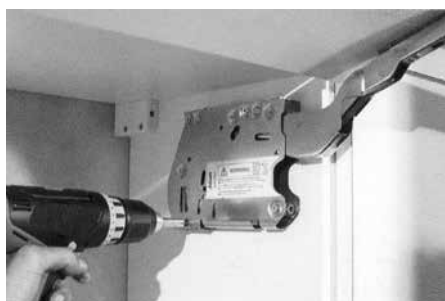
Finjustering med skruvdragare
